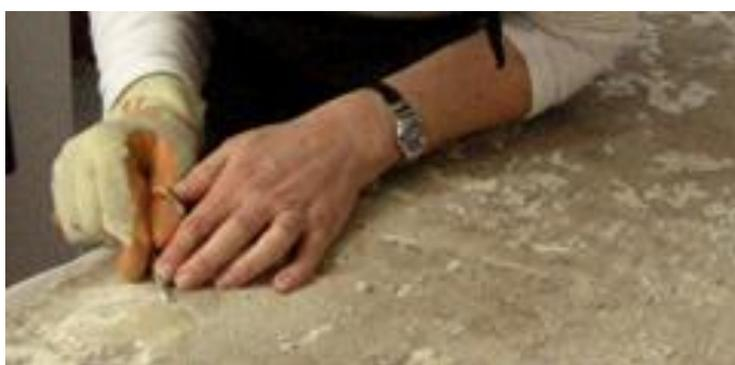
Figure 24 : dégagement de la cêruse avec un scalpel sans mesure de sécurité
