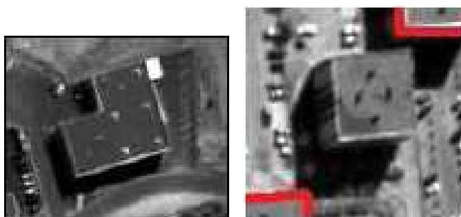
(a) Bâtiment de label G sur la scène A (b) Bâtiment de label B sur la scène B
