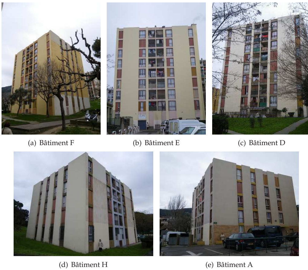
FIGURE 3.10 – Photos vérité terrain de quelques bâtiments composant la scène d'étude B.
