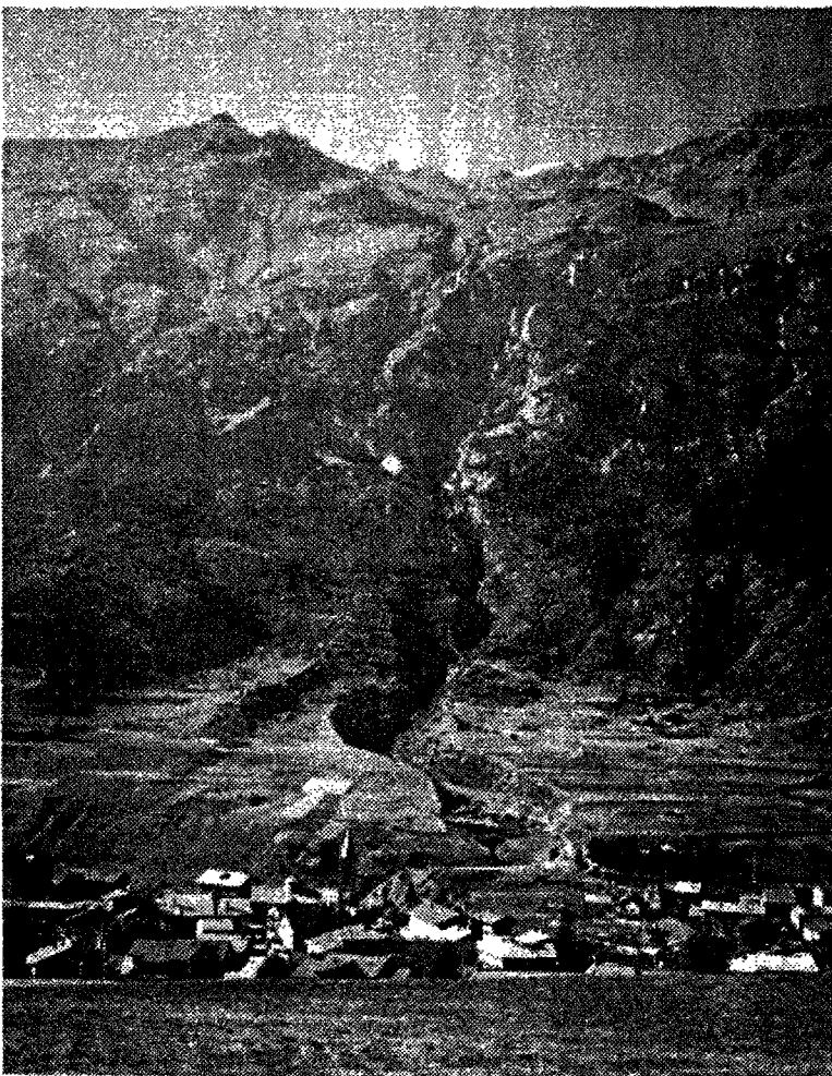
Figure 105 Lanslebourg, ruissellement et urbanisation
