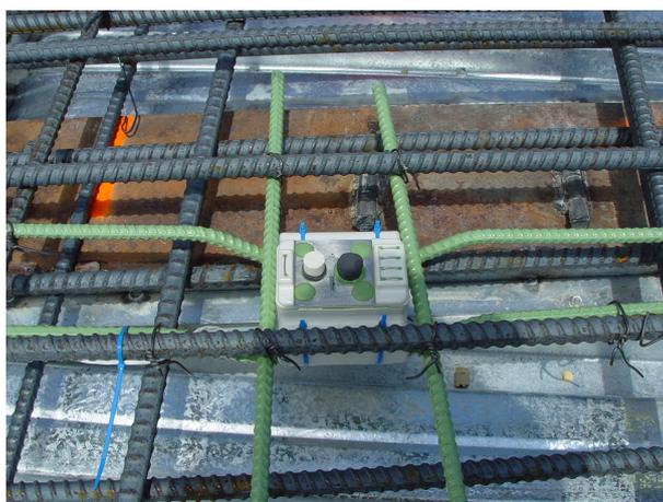
FIGURE I.3.4 – Capteur de corrosion fixé aux armatures d'un tablier de pont [Reis 06]
