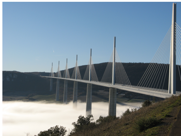
FIGURE I.2.2 – Viaduc de Millau [Virlogeux ]
