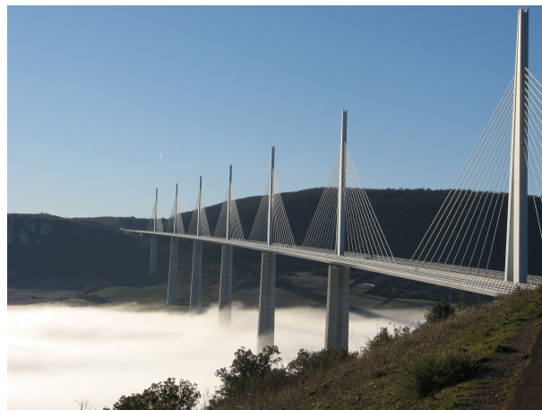
FIGURE I.2.2 – Viaduc de Millau [Virlogeux ]
