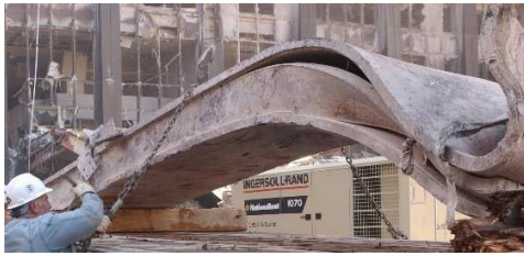
(a) Poutre porteuse flambée après un effondrement
