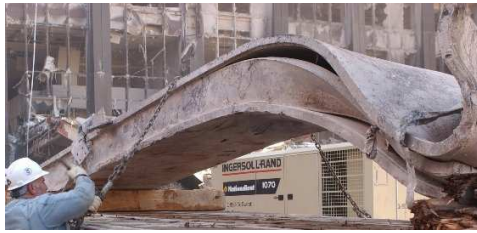
(a) Poutre porteuse flambée après un effondrement
