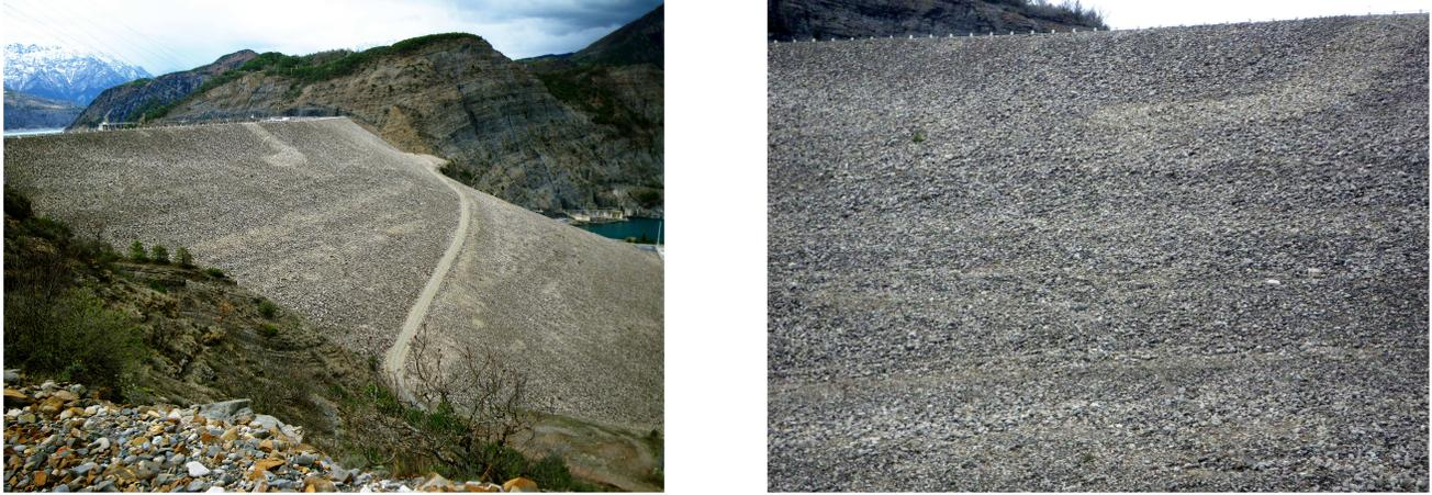
FIGURE 4.5 – (À gauche) Vue générale du barrage de Serre-Ponçon (avril 2009). (À droite) Réflecteurs élémentaires à la surface du barrage. La surface se compose de pierres de petite taille par rapport à la taille de la cellule de résolution.
