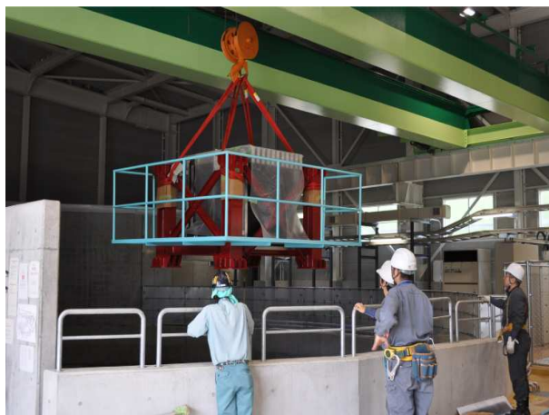
FIGURE E.5 – Descente d'un module vertical dans le puit
