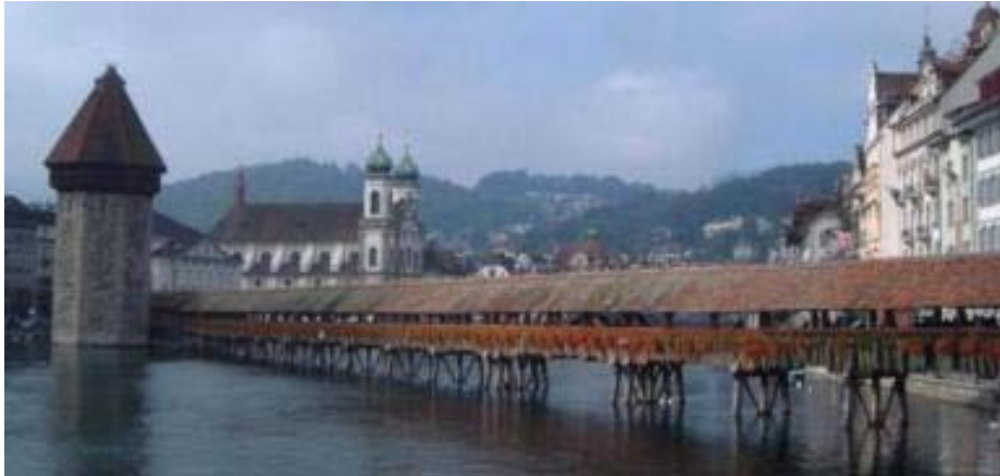
Figure 1.14. Pont de Lucerne
