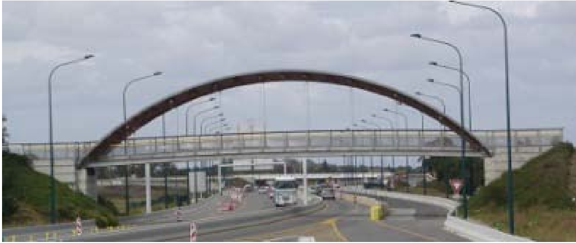
Figure 1.19. Passerelle de Pinot – Blagnac (31)
