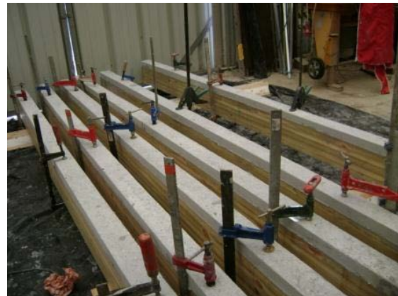
Figure 5.7. Poutres collées en cours de séchage
