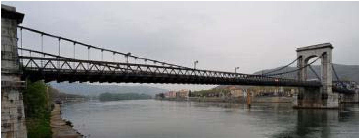
Figure 1.20. Pont Marc Seguin, Tournon, reconstruit en 1989
