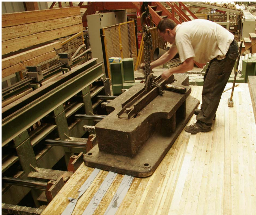
Figure 5.3. Mise sous presse et pose d'une masse en fonte pour stabiliser l'ensemble
