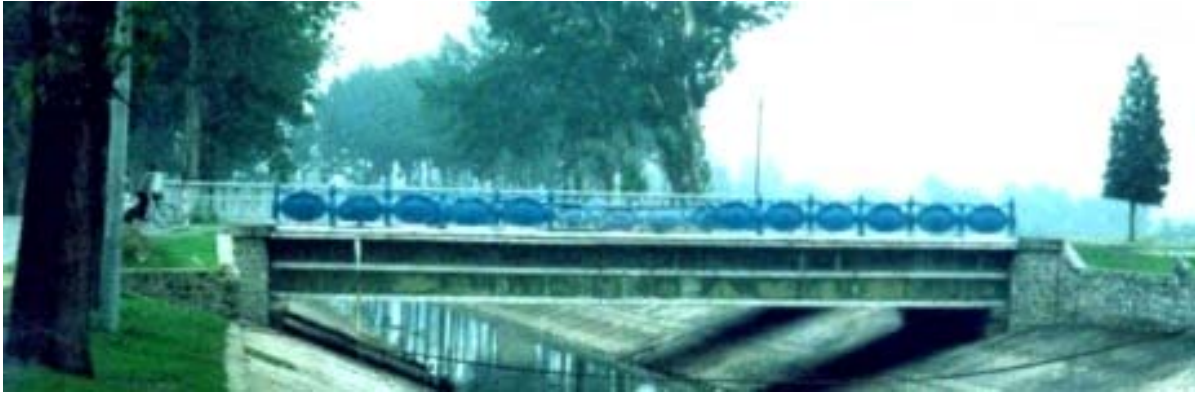
Figure 1.34. Pont Miyun - le premier pont en GFRP du monde, 1982, Pékin, China. Longueur 20.7m ; Largeur 9.2m. Dalle de type nid d'abeille en GFRP.
