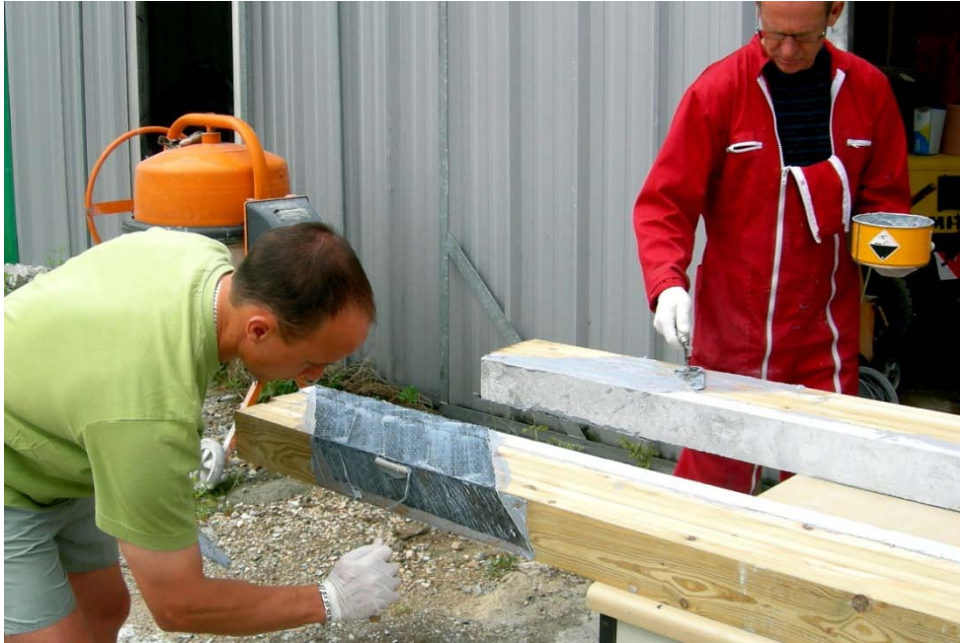
Figure 5.8. Renforcement au cisaillement des extrémités des poutres
