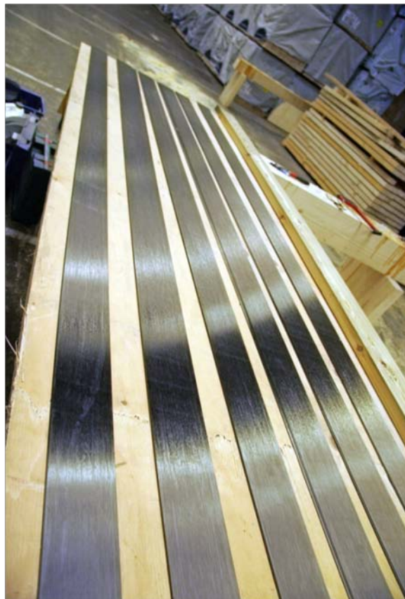
Figure 5.1. Lamelles de carbone nettoyées avant encollage
