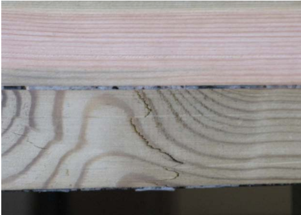
Figure 5.46. Fissure en traction stoppée par la lame de carbone intermédiaire
