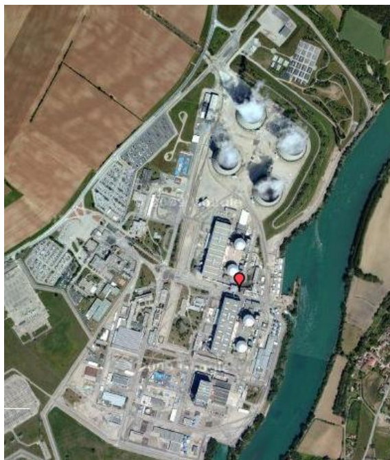
FIGURE 4.1 – Le site nucléaire du Bugey. Origine : Google Maps
