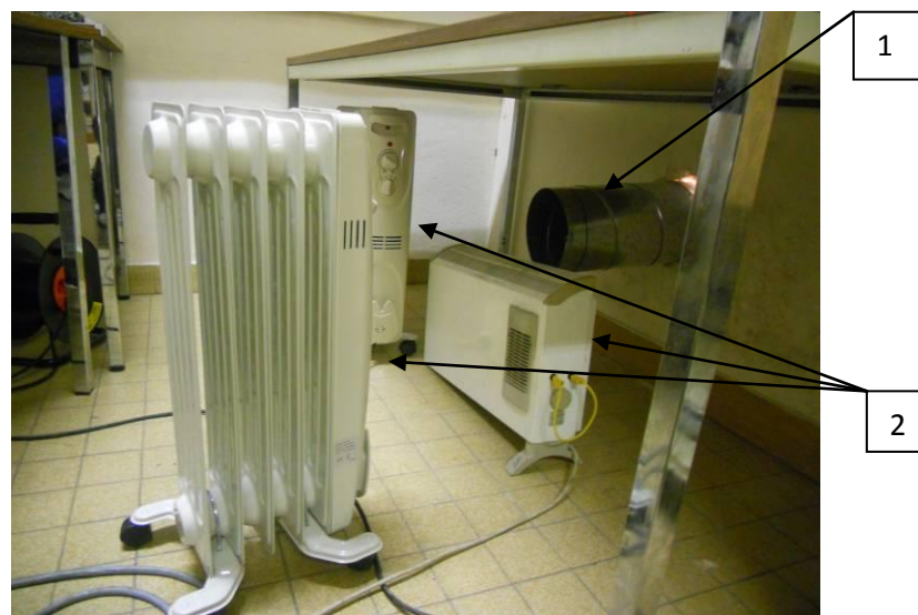
Figure 101 : Espace (salle A) où est effectuée la mise en température. (1) gaine d'entre d'air de la salle A à la salle D, (2) radiateurs qui permettent de chauffer la salle A.
