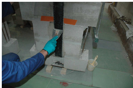
Figure 5.19 — Mise en place du TFC
