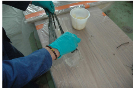
Figure 5.14 — Préparation de la mèche
