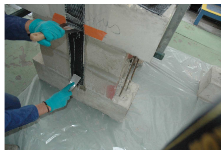
Figure 5.12 — Mise en place du TFC
