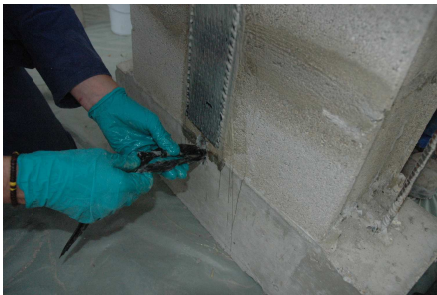
Figure 5.15 — Scellement d'une mèche
