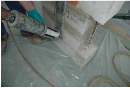
Figure 5.13 — Injection de colle dans les trous
