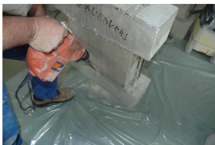
Figure 5.11 — Perçage des trous d'ancrage
