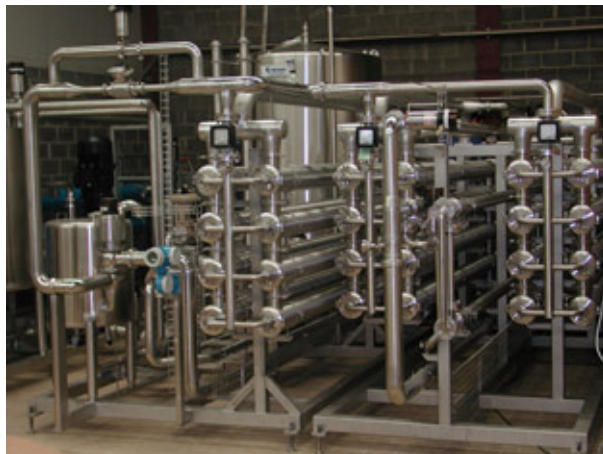
FIGURE 1.5 – Exemple d'une installation de contacteurs membranaires (ultrafiltration) à l'échelle industrielle pour la production de fromages frais (Source : Tecnal)
