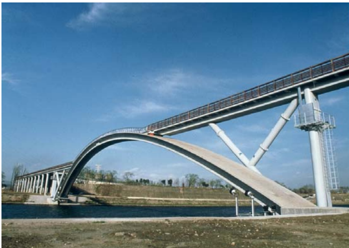
# 1 : passerelle de la paix à Séoul, réalisée en BFUP, architecte Rudy Ricciotti
