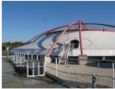
(a) Décanteur primaire
