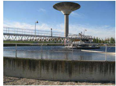
(c) Décanteur secondaire
