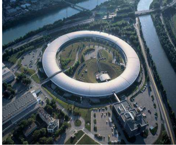
Figure IV-5 : Vue d'ensemble de l'ESRF
