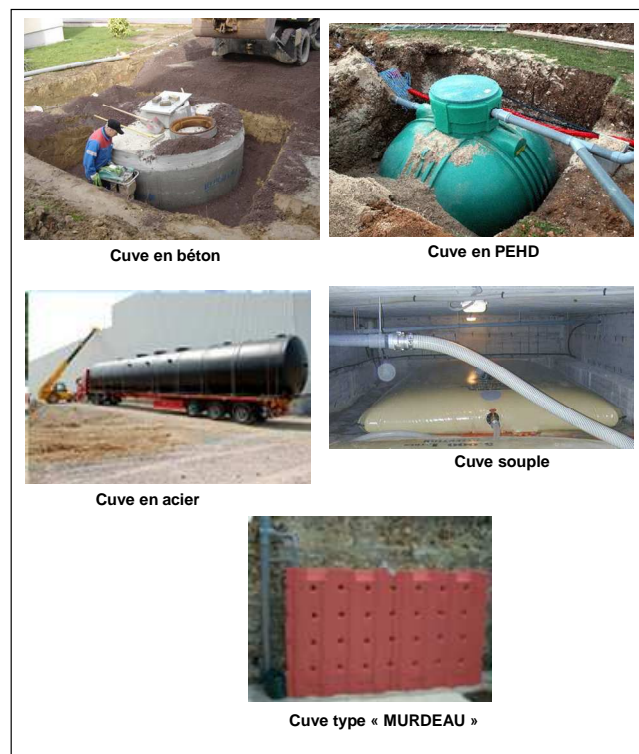
Figure 9. Différents types de cuves de stockage de l'eau de pluie.
