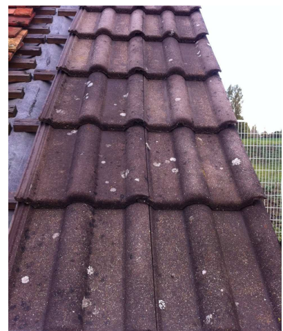
Béton Nord (13 mois)
