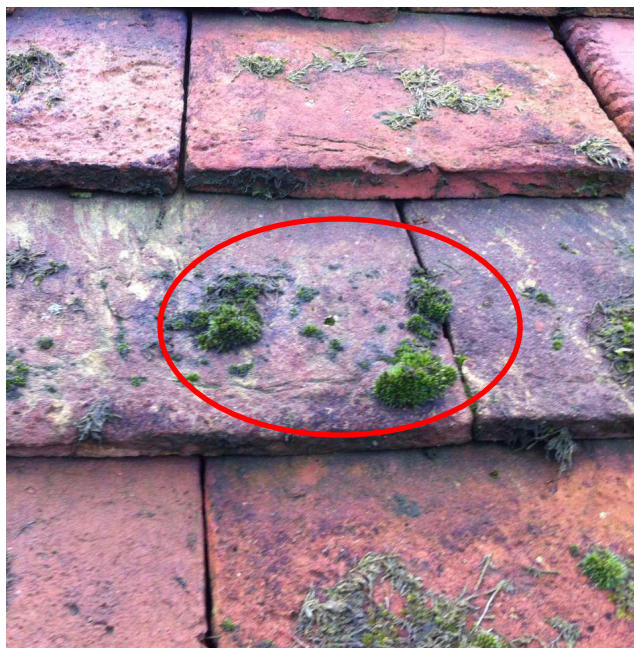
Figure 45 : Gros plan sur le développement de mousse d'une tuile terre cuite du pan Nord
