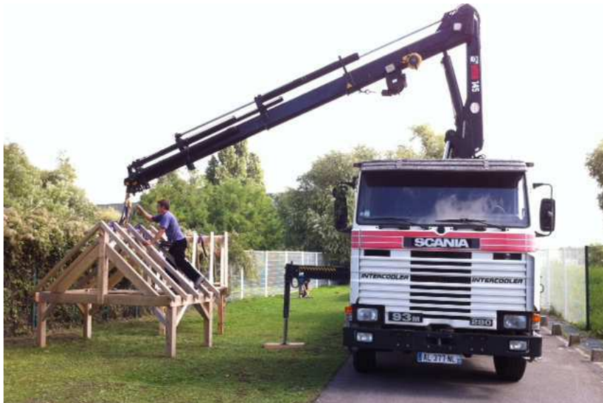
Figure 42 : Installation des charpentes utilisées pour les bancs d'essais
