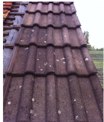
Béton Nord (13 mois)
