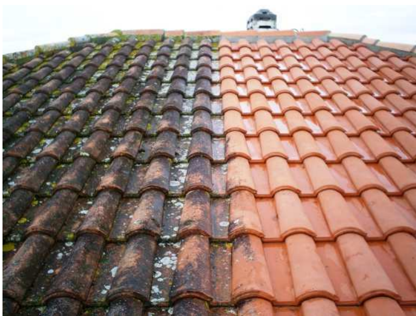
Figure 2 : Exemple d'une toiture avant et après traitement biocide (source : http://www.habitat-conseil-sud.fr )
