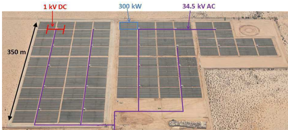
FIGURE 5.6 – Connexions de la ferme solaire « Blythe » de 21 MW aux USA
