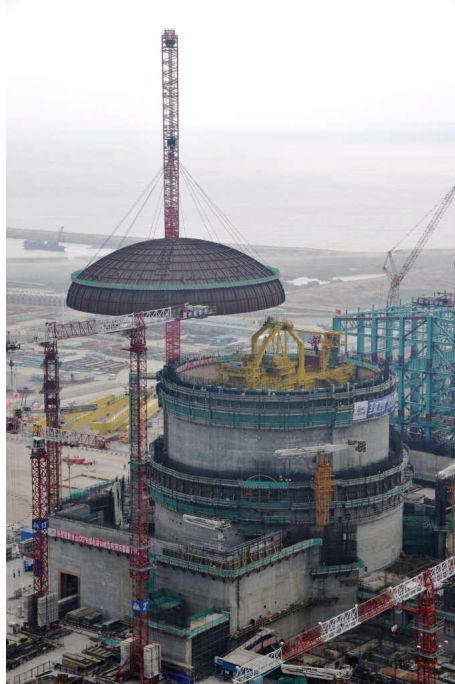
FIGURE 1.3 – Enceinte de confinement d'un EPR de Taishan lors de la mise en place du dôme.
