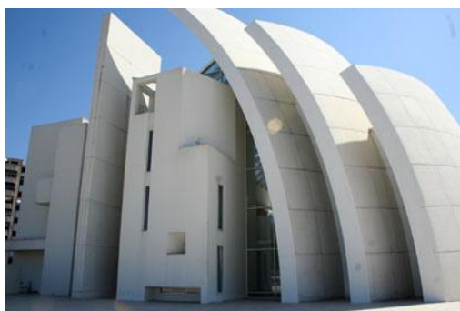
Figure 1.5 : église du Jubilé à Rome, contenant du TiO 2 nanométrique dans son ciment 12 .
