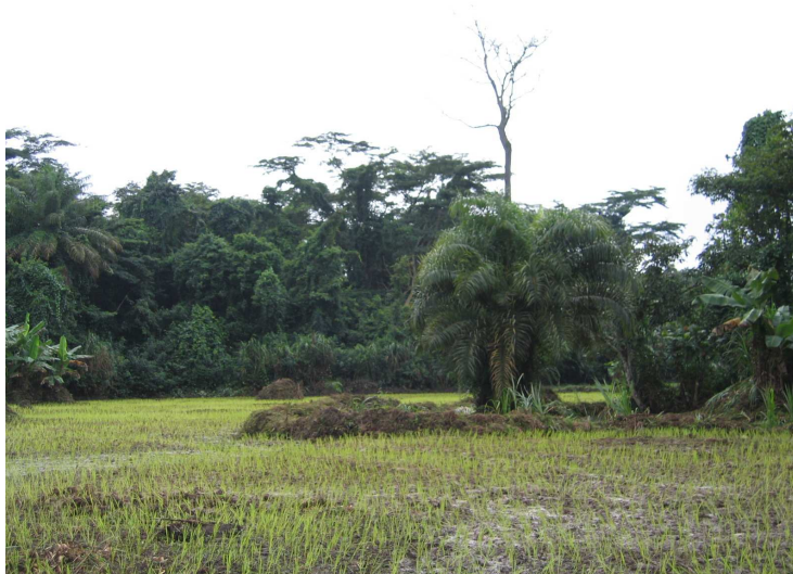
Photo 31 : Digue en herbes le long du cours d'eau (Gbouo, 07/05)
