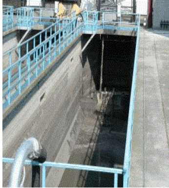
Déversoir d'orage de Clichy
