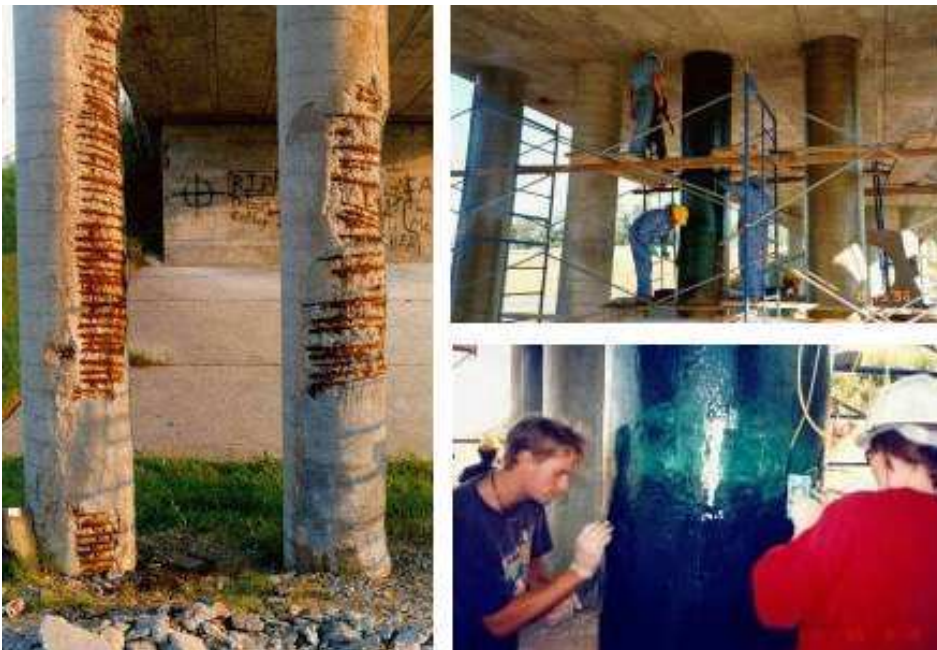
FIG. 0.0.6 – Réparation de colonnes en béton armé par collage de composites pré-imprégnés. Images empruntées à ISIS Sherbrooke
