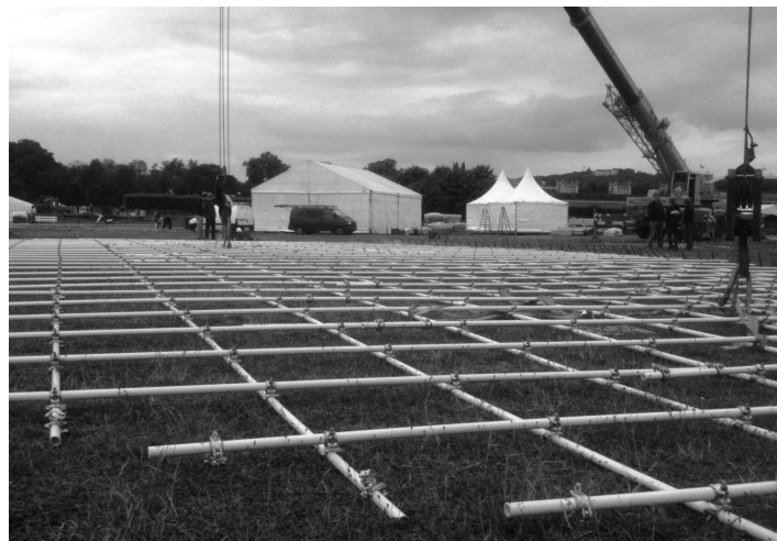
FIG. 0.0.2 – Grille assemblée à plat au sol, image fournie par l'équipe de conception
