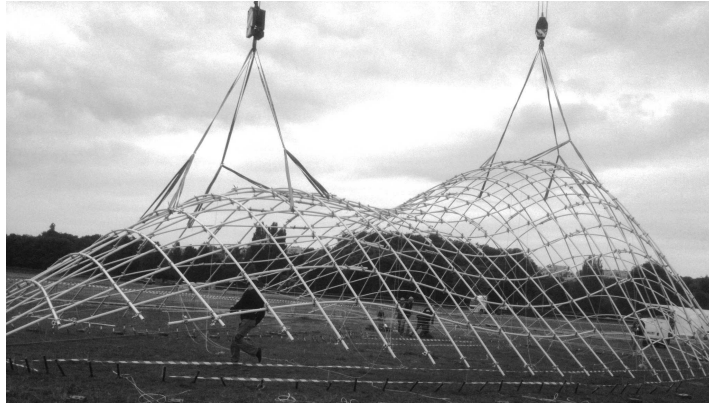
FIG. 0.0.3 – Levage de la grille, image fournie par l'équipe de conception
