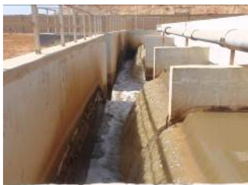
Eau traitée avant rejet en mer
