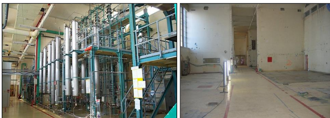
Figure 6 : Atelier D des ATUE à la fin de son exploitation (à gauche) et après la dépose des procédés (à droite)
