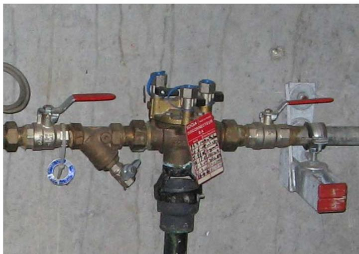
*Figure 0-3 : Disconnecteur de type BA installé sur le réseau intérieur d'eau potable.*
