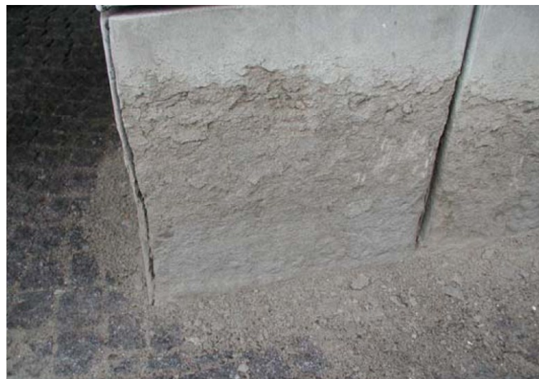
Figure 1.50 Roche calcaire poreuse présentant un degré de saturation supérieur à 95% et une forte détérioration au gel-dégel (fissures et écaillage) – façade d'immeuble, Copenhague, Danemark d'après [I-Stone, 2006]
