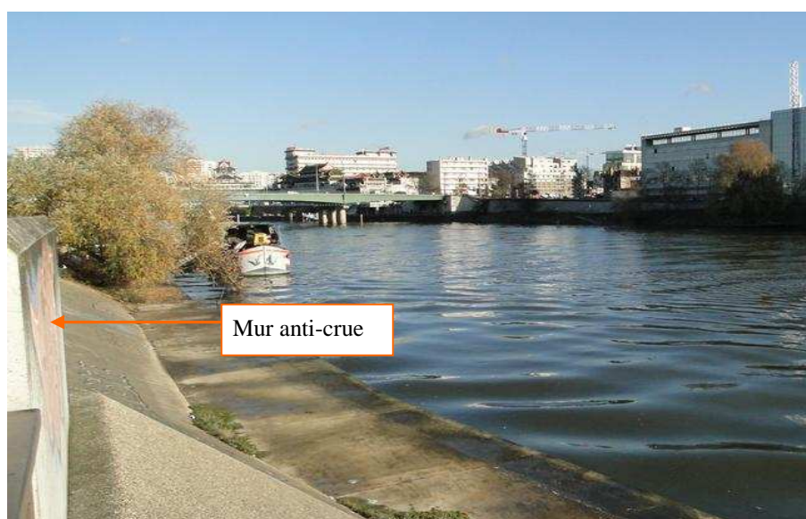
Photo 22 : Mur anti-crue en bordure de Seine à Ivry (Photo prise en décembre 2011, Beraud)
