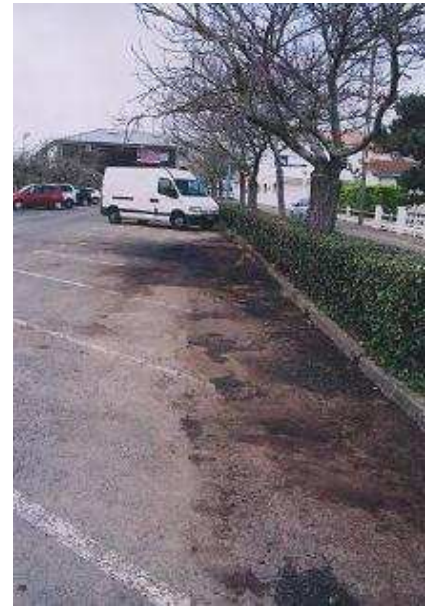
Photo 5 : Traces d'hydrocarbures sur un parking ayant servi de zones de stockage temporaire pour les déchets de Xynthia à la Faute-sur-Mer (Robin Des Bois, 2010)
