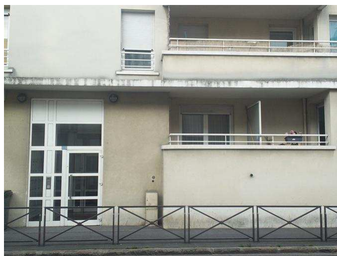
Photo 25 : Immeuble de la rue Molière (Cliché : Vaujany, juillet 2012)
