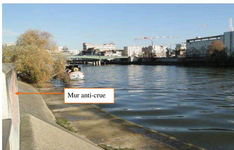
Photo 22 : Mur anti-crue en bordure de Seine à Ivry (Photo prise en décembre 2011, Beraud)
