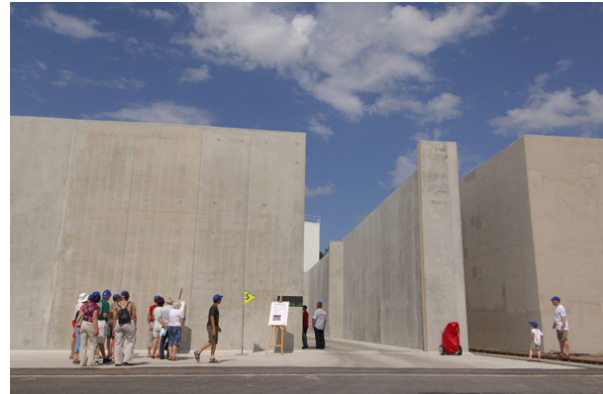
FIGURE 1.4 – Ouvrages de stockage avant remplissage (Andra (2011)).
