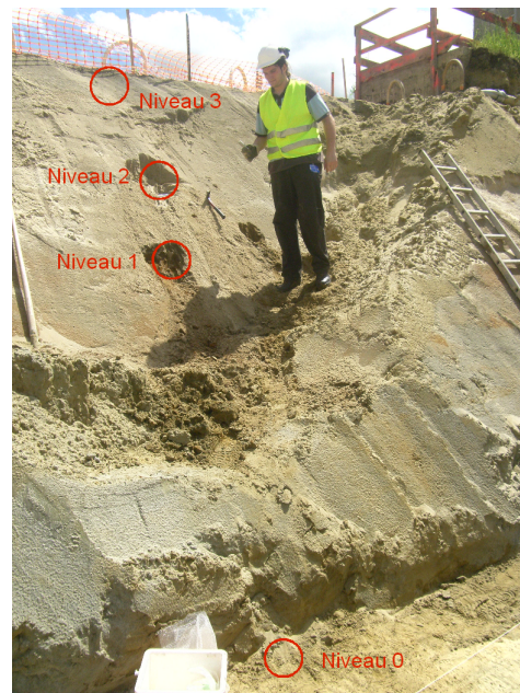
FIGURE 3.8 – Vue de l'emplacement des quatre carottages.
