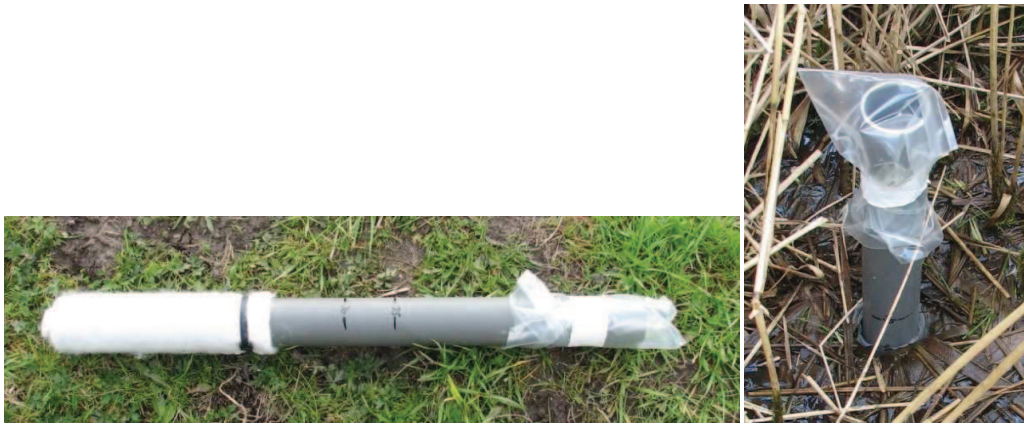
Figure II-17 : L'un des piézomètres installés dans la roselière, avant installation (à gauche) et une fois posé (à droite). Photos : J. Haury.
