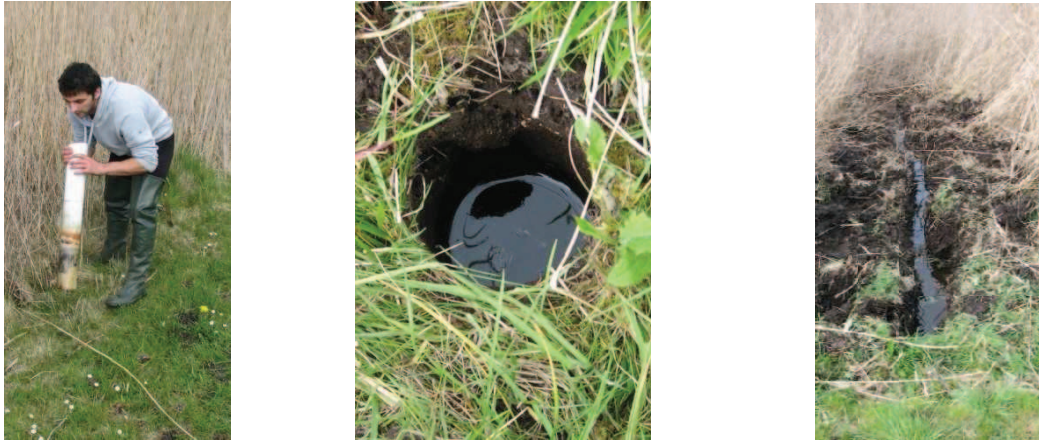
Figure II-15 : Remise en service des puits : Le tuyau PVC qui avait été placé autour du puits a été ôté (photo de gauche). A cause de l'accumulation de matière organique au cours des années, la pression au niveau des puits n'était pas suffisante pour causer une circulation d'eau(photo du milieu) et il a fallu creuser un petit canal pour faciliter le passage de l'eau sur quelques mètres (photo de droite). Photos : J. Haury.
