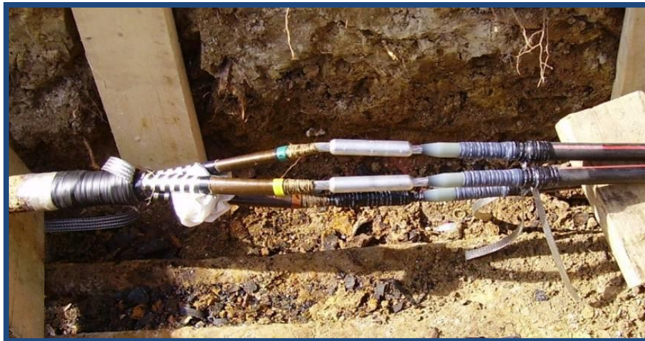
Figure 3. Photographie d'une transition en cours de fabrication.
