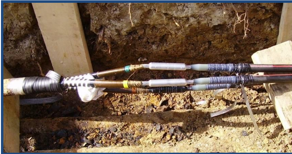
Figure 3. Photographie d'une transition en cours de fabrication.
