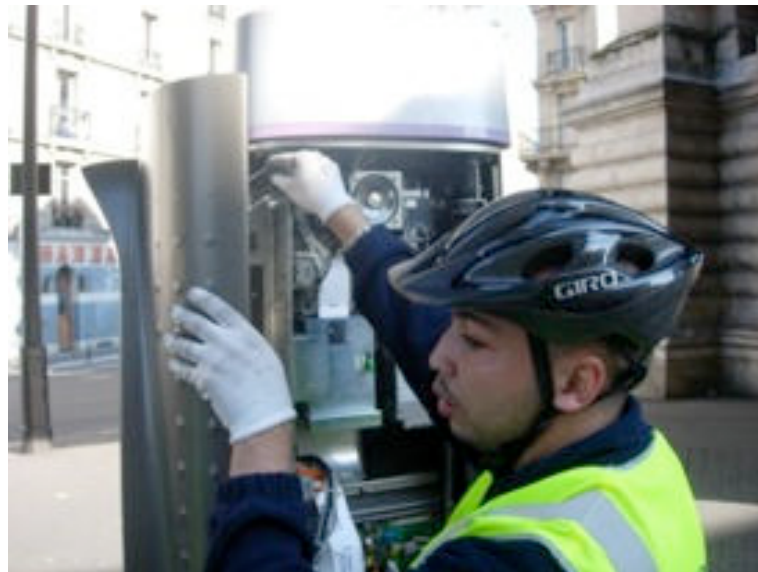
Figure 11 : Le TC2 en train de réparer la Lanbox de la borne
