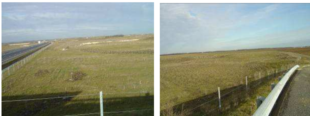
Figure 3-24 : Photographies du Mont-aux-liens-secteur nord. Janvier 2010.
