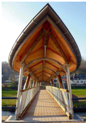
Figure 1-3 : Passerelle mixte bois-acier de La Rochelle en Ardenne ( http://www.houtinfo Bois.be ).
