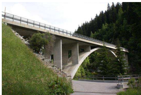
Figure 1-5 : Pont la "Resgia" en Suisse ( http://fr.structurae.de ).
