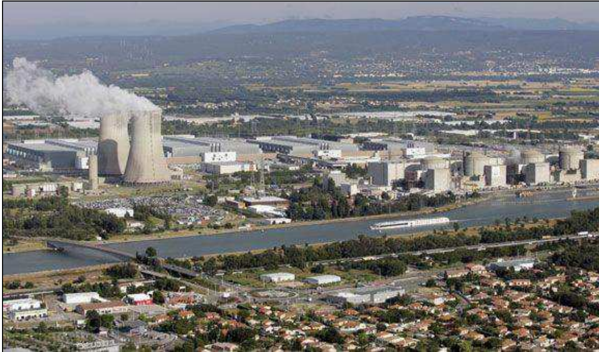
Photo 3.4 : Centrale du Tricastin et canal d'aménée de Donzère-Mondragon
