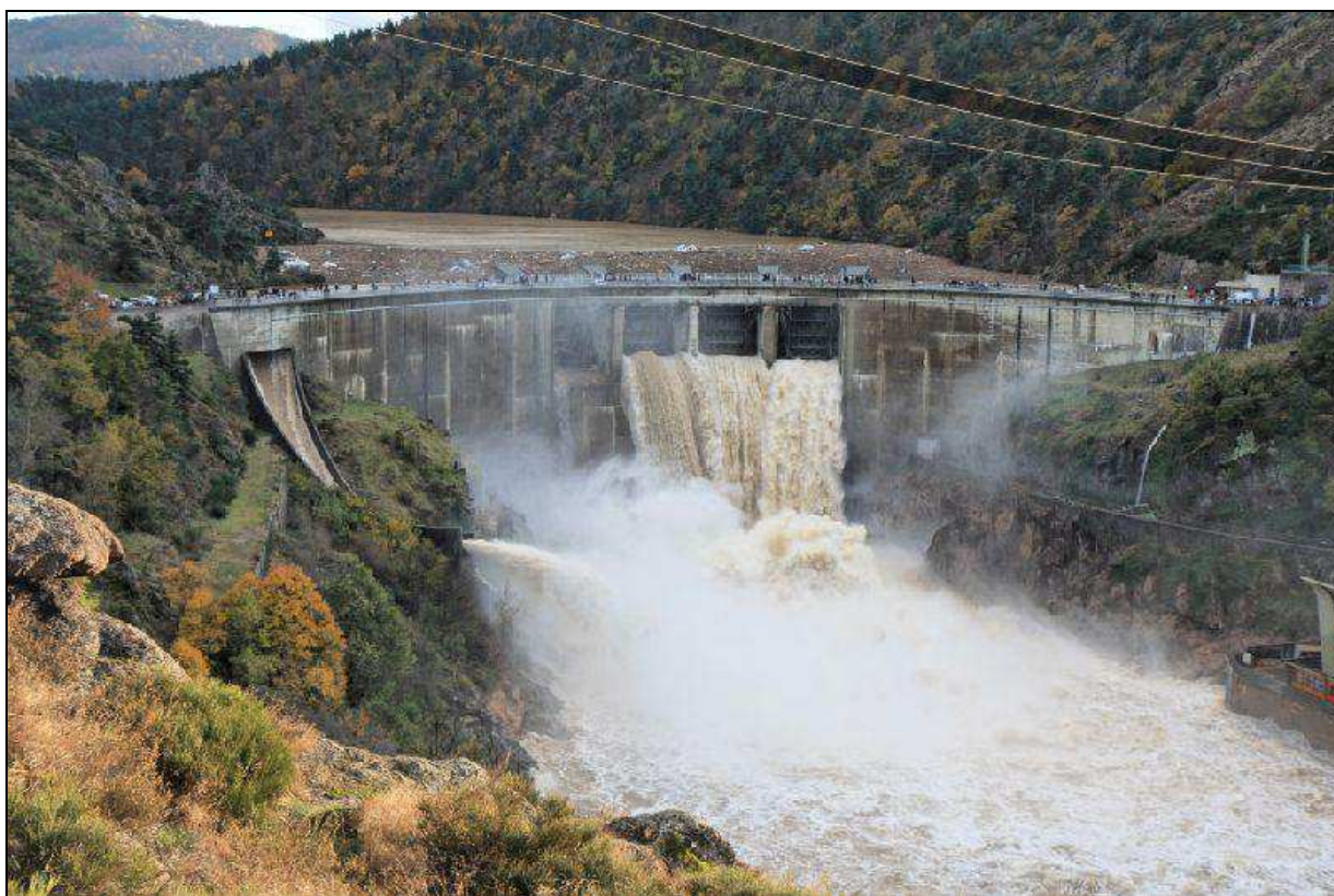
Photo 5.2 : Lâcher de barrage lors de la crue de 2008
