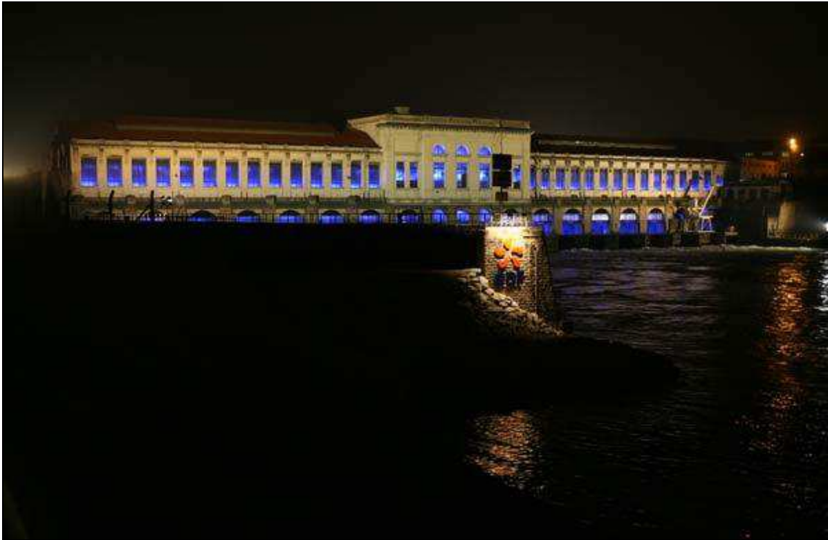
Photo 5.9 : Illumination de l'usine de Cusset
