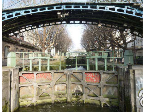
Annexe 1. 30: Écluse 6 des Récollets (Canal Saint-Martin)
