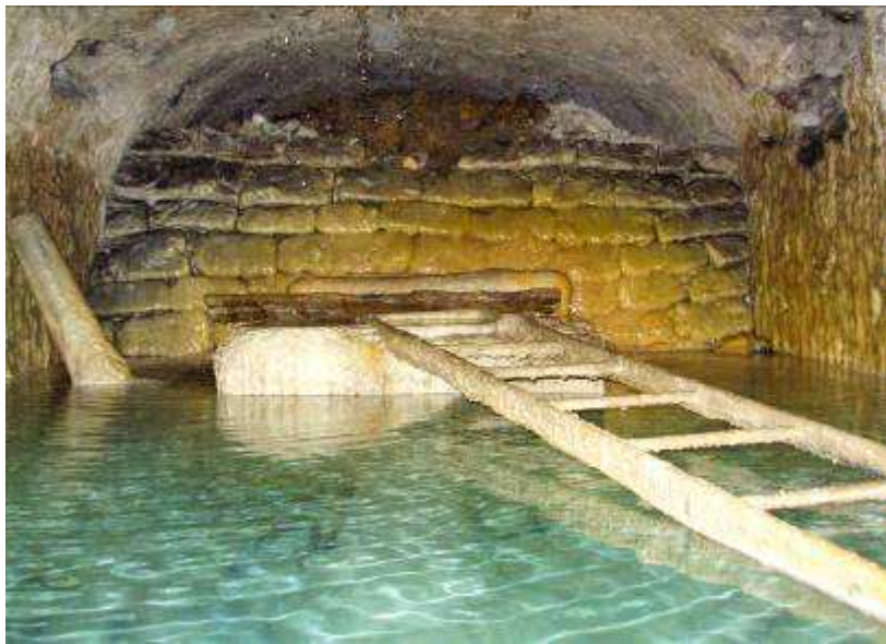
Infiltration d'eau dans une carrière
