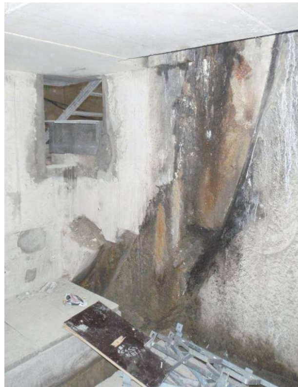
Figure 1. 103: Venues d'eau polluée au niveau de la jonction entre un tunnel et une station de métro. (photographie A. Lamé)
