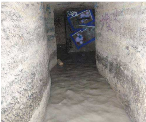
Figure 1. 86: Fuites de réseaux en carrière (photo A. Lamé et IGC).
