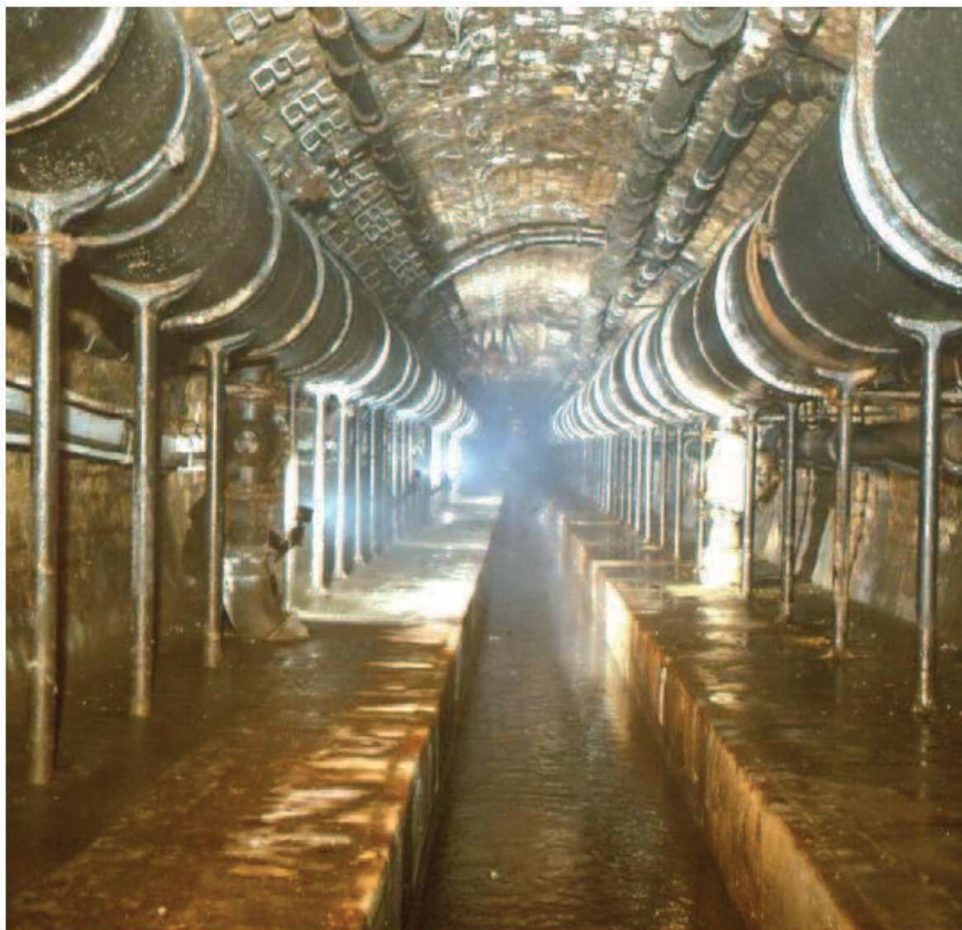
Annexe 1. 33: Collecteur Sébastopol (photo: Section de l'Assainissement Parisien)
