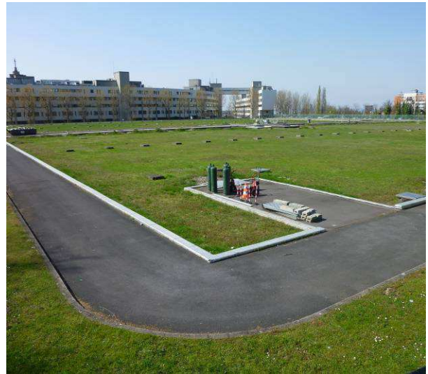
Annexe 1. 37: Réservoir des Lilas
