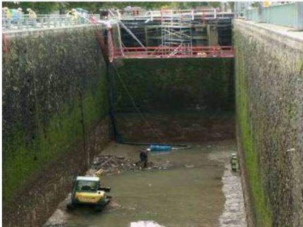
Annexe 1. 29: Nettoyage d'une écluse du Canal Saint Martin (photographie de Jean-Louis Bernasconi)
