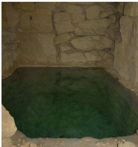
Figure 1. 85: Puits en carrière dans Nappe du Lutétien (bain des carriers).
