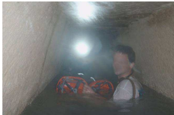
Figure 1. 86: Fuites de réseaux en carrière (photo A. Lamé et IGC).
