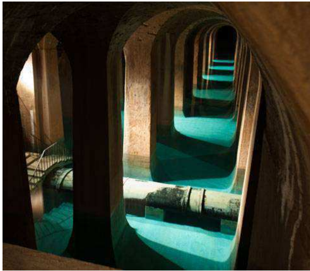
Annexe 1. 36: Réservoir Montsouris (Mairie de Paris - François Grunberg)
