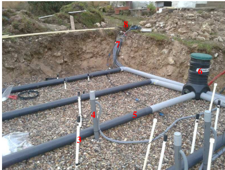
Figure 33. A-1. Etat de l'instrumentation le 20 décembre 2011. A-2. Installation d'une plaque poreuse. B. Etat de l'instrumentation le 20 janvier 2012 : 1. Le sable de granulométrie normalisée. 2. Le collecteur des tubes connectés aux plaques poreuses déjà enfouies. 3. Une canne de tensiomètre. 4. Un tube de réservation pour une sonde de teneur en eau. 5. Un tuyau d'épandage des eaux usées prétraitées. 6. La boîte de répartition. 7. Le regard pour regrouper les tubes en téflon et les câbles. 8. Le départ de la tranchée d'aménée des tubes et des câbles vers les pompes et la centrale d'acquisition dans la cave.
