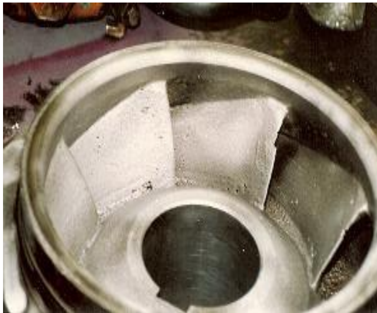
Figure 2 – 5 : Effet de la cavitation (et/ou érosion) sur la roue d'une pompe centrifuge - Service de fond de colonne unité distillation dans une raffinerie de pétrole
