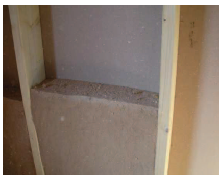
Figure 141. Isolation des murs entre montants, double vitrage peu émissif avec lame d'argon
