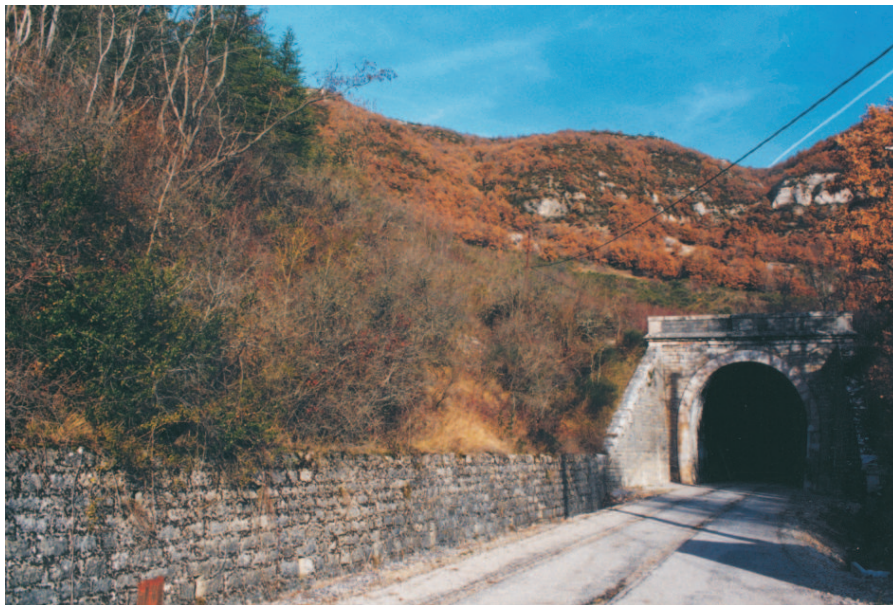
Figure 1.3: Entrée sud du tunnel de Tournemire
