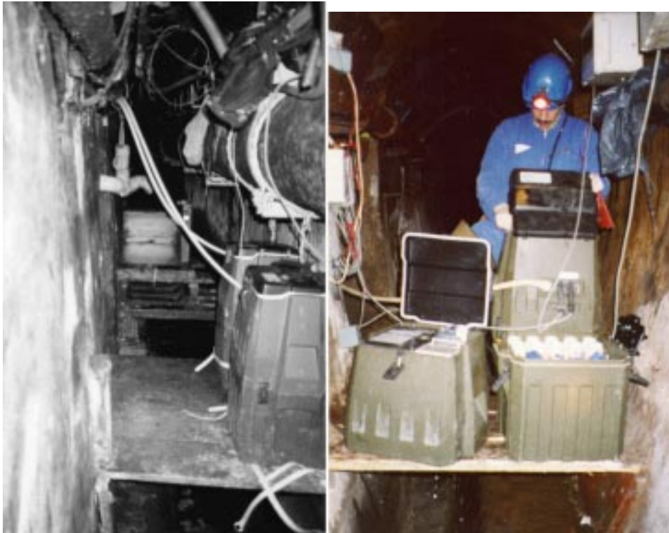
Avaloir «Vieille du Temple », drainant les rues Rosiers et Marché des Blancs Manteaux
