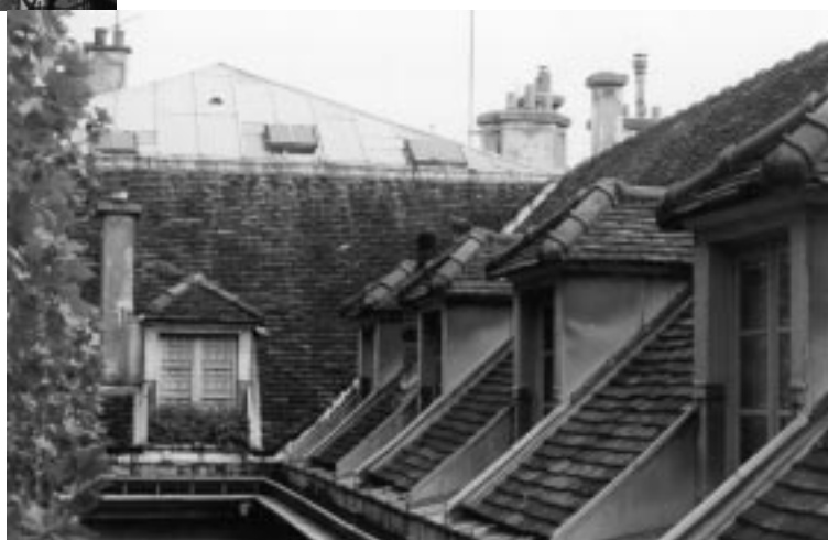
Toiture Tuile 2 (tuile plate et zinc)
