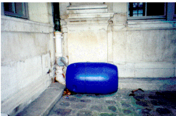
Collecte des eaux de ruissellement, toiture Tuile 2
