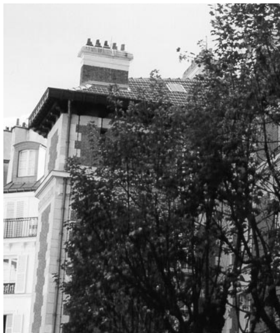
Toiture Tuile 1 (tuile mécanique)
