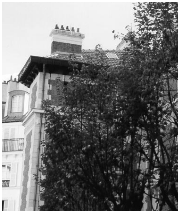
Toiture Tuile 1 (tuile mécanique)
