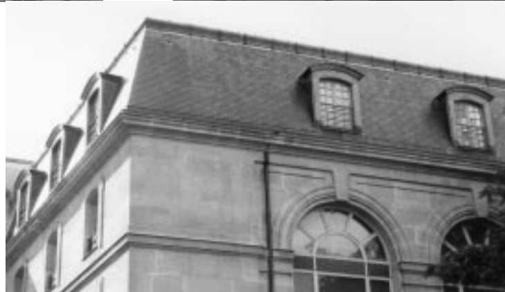
Toiture Ardoise Z
