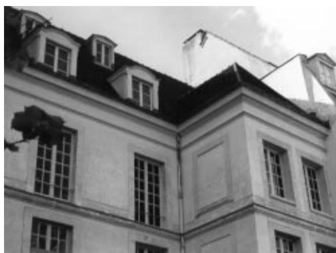
Toiture Tuile 3 (tuile plate)
