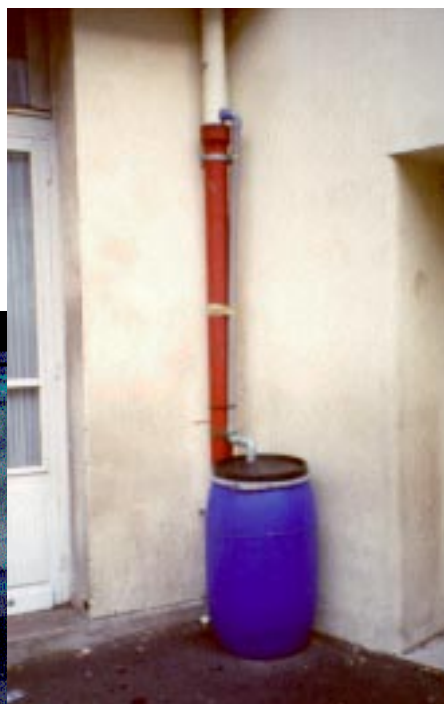
Collecte des eaux de ruissellement, toiture Zinc 1
