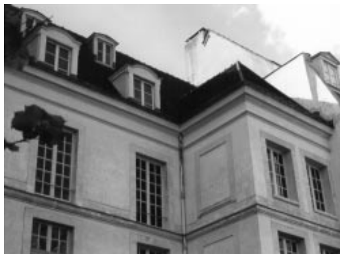
Toiture Tuile 3 (tuile plate)
