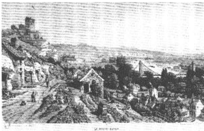
Figure 53 Vue générale prise de la vieille route de Gasny (côté de Vétheuil) par Adolphe Maugendre vers 1850. Planche 17 (cf. table des figures) [201].
