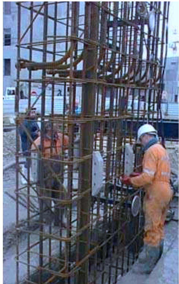
Fig. 4-11 : Cage instrumentée en cours de descente dans la tranchée remplie de boue
