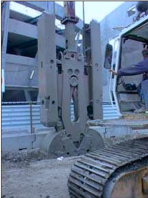
Fig. 4-10 : Outil de perforation à benne hydraulique monté sur un bâti de guidage Kelly-Solétanche équipé d'un jeu de poches 800 x 2700 (parois d'épaisseur de 0,80m)
