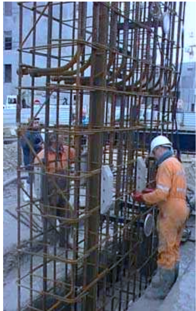
Fig. 4-11 : Cage instrumentée en cours de descente dans la tranchée remplie de boue
