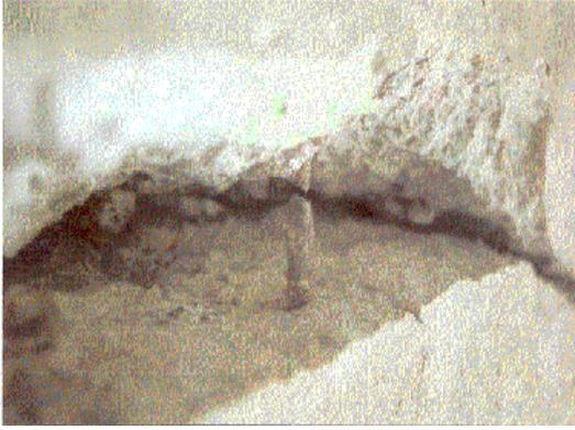
FIG. 1.1 – *Dégradation locale de l'alcali-réaction (LCPC 1999)*
